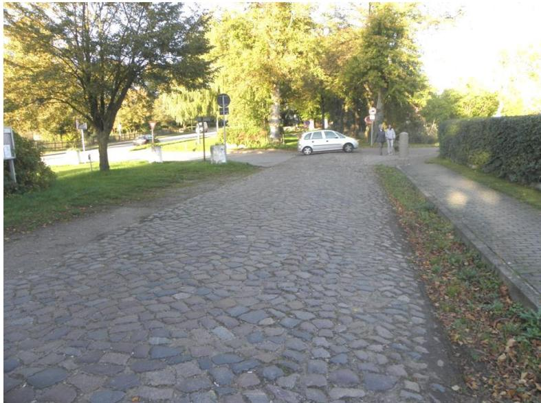
Straße am Bord aufhöhen, Natursteinbord neu setzen, Betonkeil am Bord entfernen Gehweg und Straße neu pflastern, Borde werden wiederverwendet
